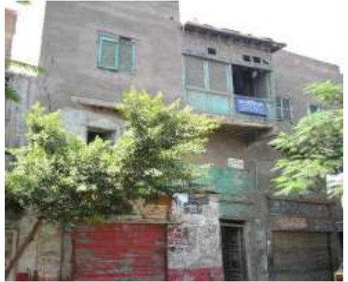
لوحة (١٥) الواجهة الشمالية الشرقية: المدخل بالواجهة ويعلوه شرفة خشبية ويؤدي المدخل إلى مرافق المنزل
