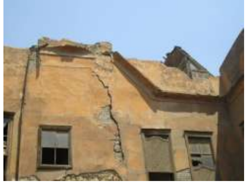
لوحة (ج٩) الجانب الجنوبي الشرقي: جزء من الطابق الثاني وتظهر به الشبابيك الشيشة والأزار الحجري الإهسايي وكتلة الملقف (البأههه)
