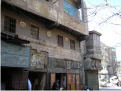
لوحة (٣) الواجهة الجنوبية الشرقية: المدخل الثاني ويقع في أقصى الواجهة برج الخفارة للمنزل، ويتضح في اللوحة الشبابيك المربعة الصغيرة للدور المسروق أعلى المدخل المذكور
