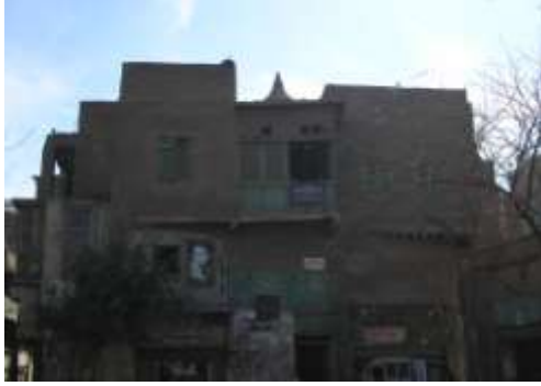
لوحة (٥ب) الواجهة الشمالية الشرقية: يتضح فيها الطابقان الأول والثاني ويظهر البرج المخروطي الشكل خلف الطابقين
