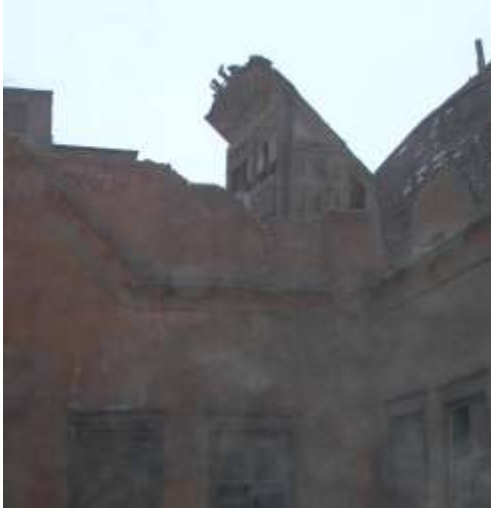
لوحة (د٩) الجانب الجنوبي الشرقي (من الداخل) الملقف (البأههه)
